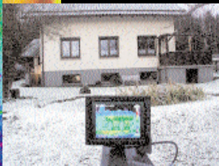
サーモカメラは小さな熱のロスも見逃さず、その場ですぐ建物の弱点を発見する
